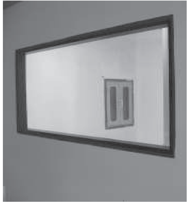
Figura 5: Modelos de visores em vidro para insetário, entre ambientes na parede.
