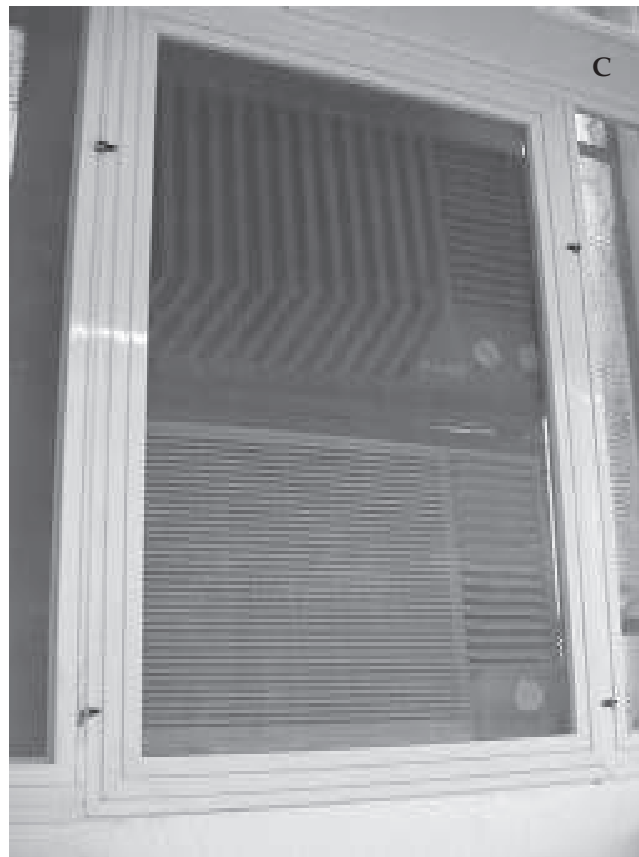
Figura 12: Exemplos de fechamento com tela do sistema de condicionamento de ar para insetário. (A) fechamento com porta. (B) detalhe do trinco da porta mostrada em A. (C) fechamento com perfil de alumínio, telado, removível. (D) detalhe do trinco com perfil mostrado em C.
