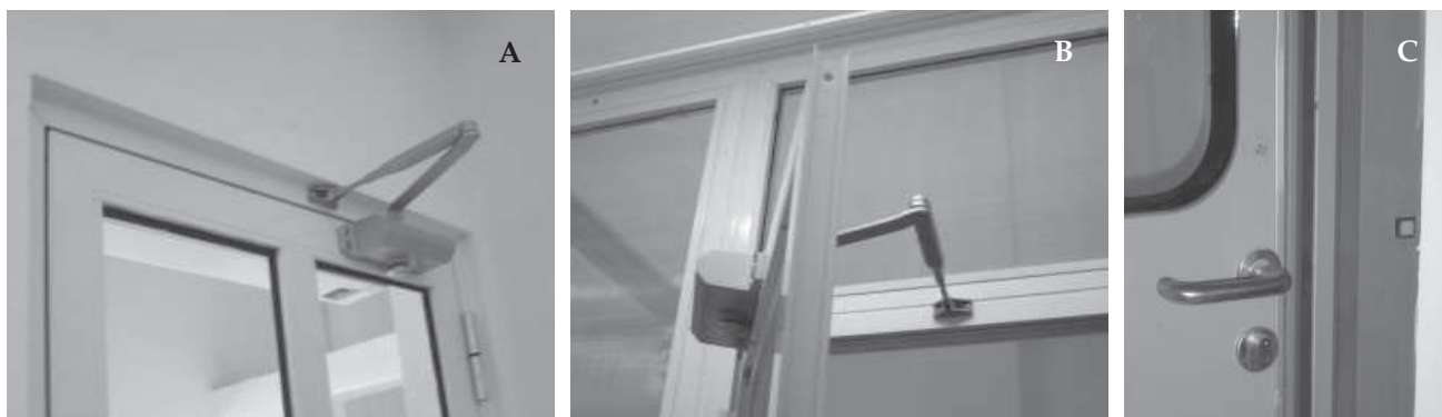
Figura 2: Sistemas usados para fechamento de portas. (A, B) fechamento com mola. (C) fechamento com botoneira.
