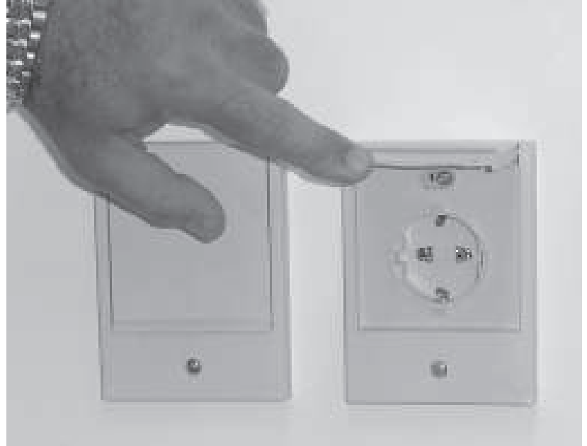
Figura 10: Exemplo de tomada com fechamento para evitar esconderijo de insetos.
