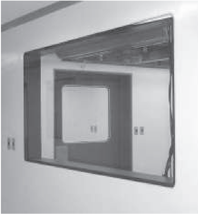
Figura 5: Modelos de visores em vidro para insetário, entre ambientes na parede.
