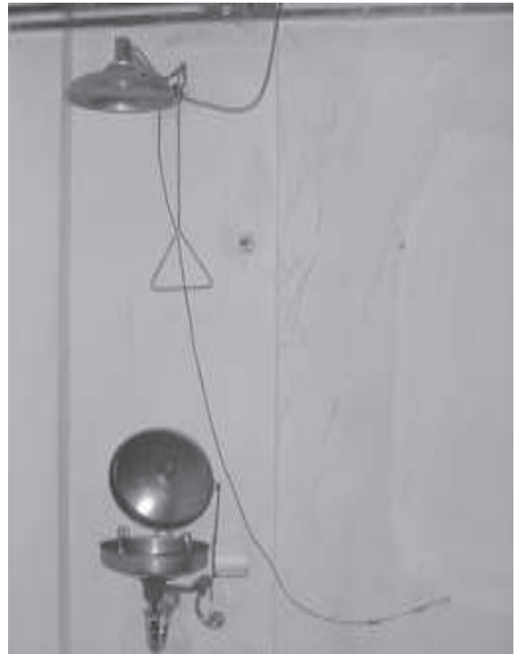
Figura 15: Modelo de lava-olhos para área de apoio ou antecâmara (infectório). O exemplo apresentado possui chuveiro acoplado.
