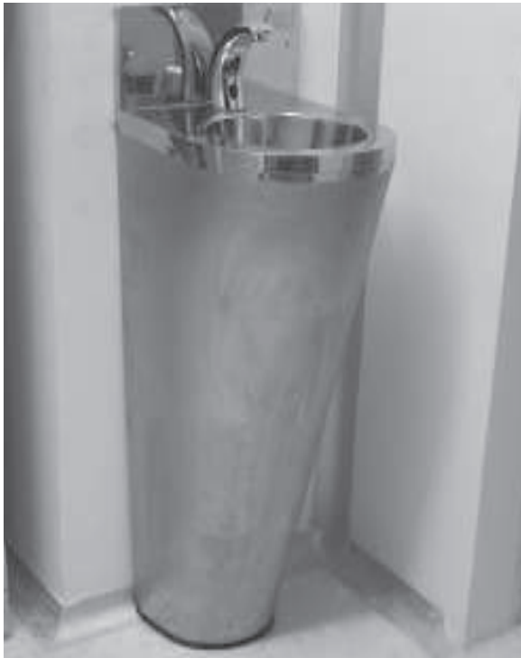
Figura 14: Modelo de pia automática para área de apoio ou antecâmara (infectório).
