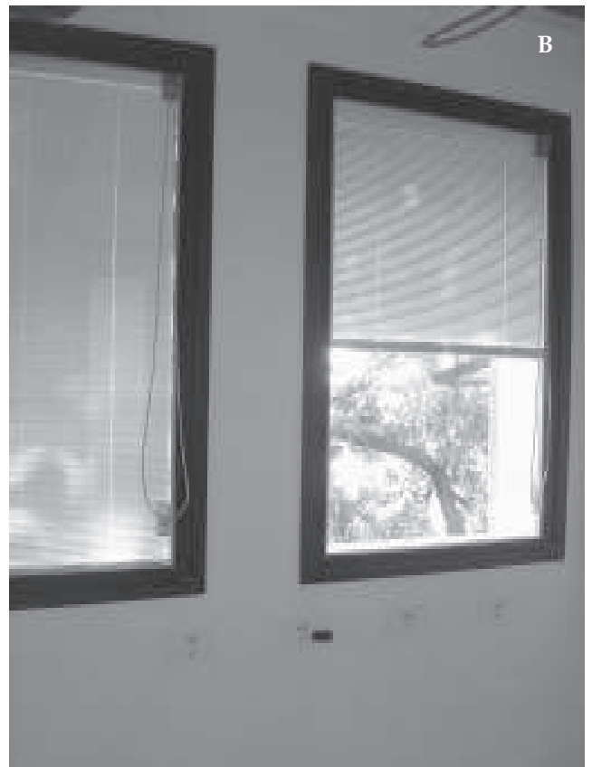
Figura 5: Modelos de visores em vidro para insetário, entre ambientes na parede.
