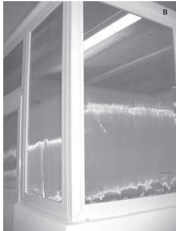
Figura 7: Exemplo de rebaixamento e de fechamento lateral com tela de aço inox (malha de 0,97 mm). (A) detalhe de rebaixamento com placas teladas, removíveis, para facilitar a manutenção do sistema de ar condicionado, que deve ficar acima do rebaixo. (B) fechamento lateral e rebaixamento em tela (perfis removíveis). A iluminação fica acima do rebaixo.
