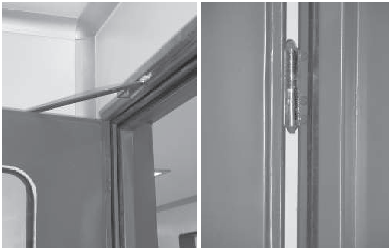
Figura 3: Exemplos de vedação de porta com encaixe tipo “macho-fêmea”.
