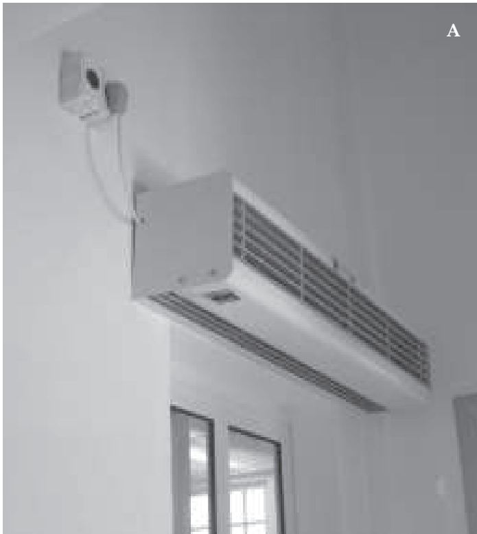
Figura 13: Modelo de cortina de ar (A) instalada sobre porta de acesso a insetário (B).
