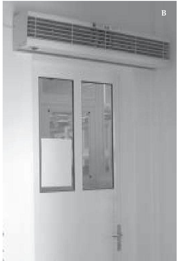
Figura 13: Modelo de cortina de ar (A) instalada sobre porta de acesso a insetário (B).
