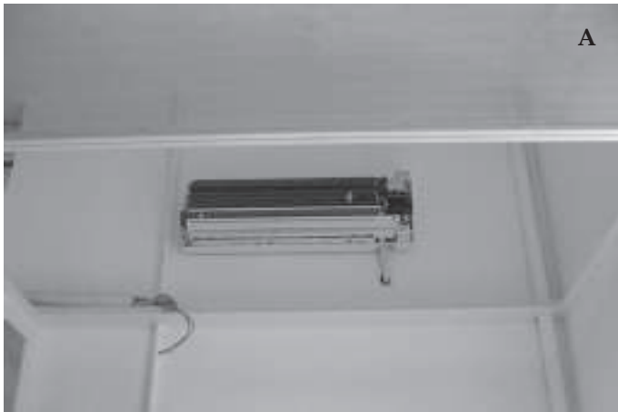
Figura 7: Exemplo de rebaixamento e de fechamento lateral com tela de aço inox (malha de 0,97 mm). (A) detalhe de rebaixamento com placas teladas, removíveis, para facilitar a manutenção do sistema de ar condicionado, que deve ficar acima do rebaixo. (B) fechamento lateral e rebaixamento em tela (perfis removíveis). A iluminação fica acima do rebaixo.
